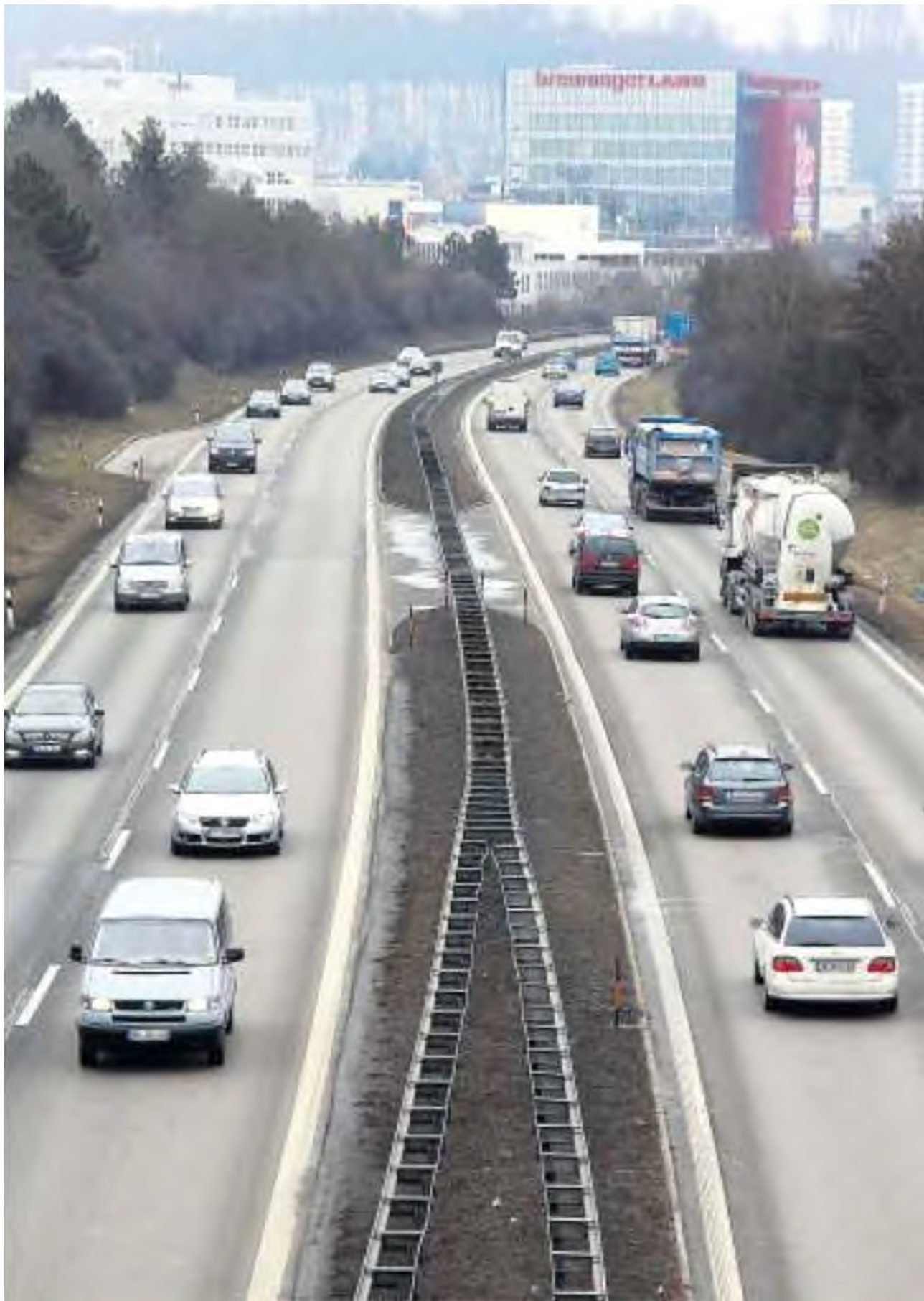
Die A 81 soll zwischen den Anschlussstellen Mblingen-Halb bis Sindelfingen-Ost sechsspurig ausgebaut werden und einen 850 Meter langen Lärmschutzdeckel erhalten. Foto: factum
